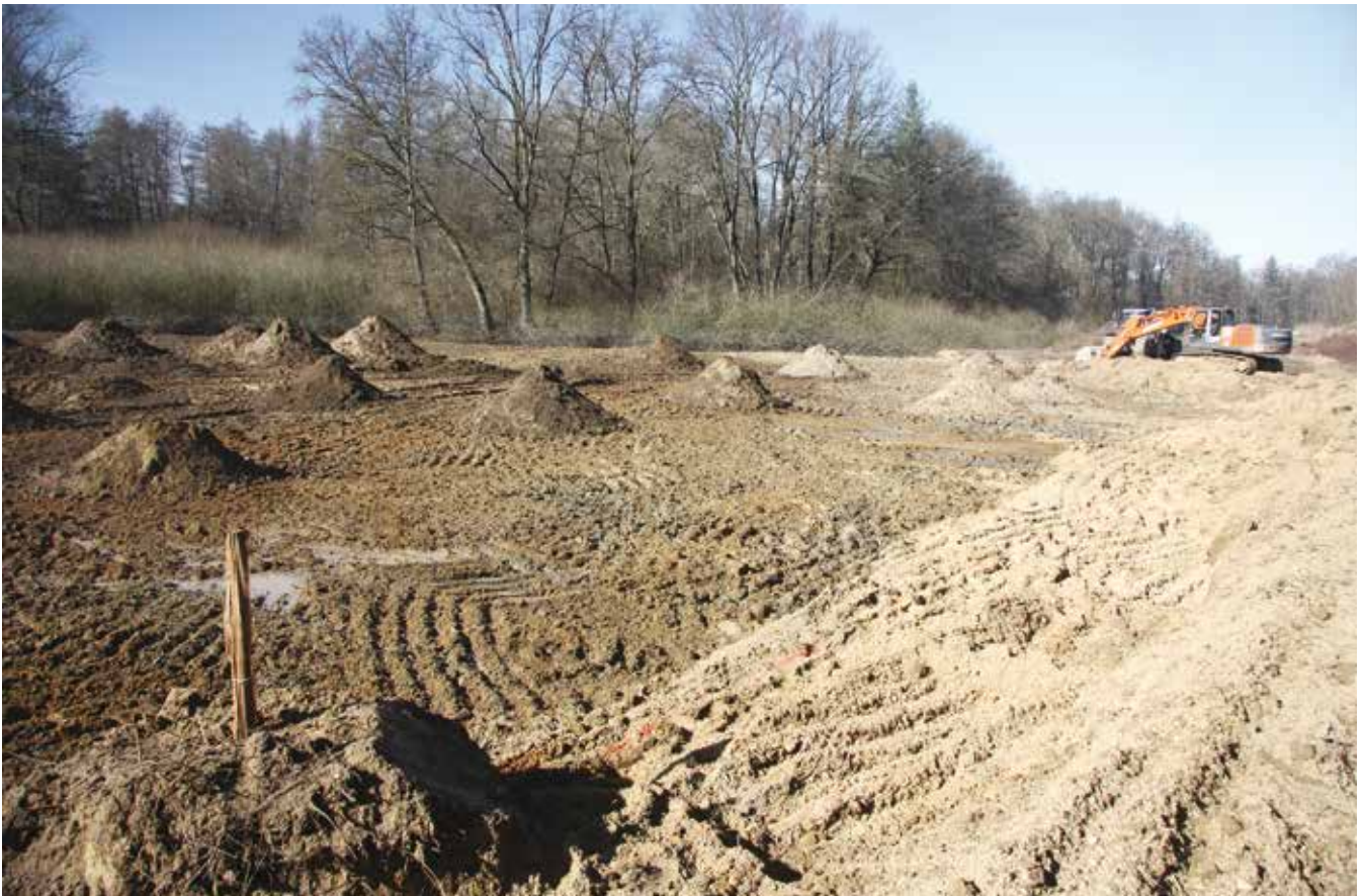
Figura 19 - Intervento di scolturamento e livellamento, nel febbraio 2019 (foto Fabio Casale).
