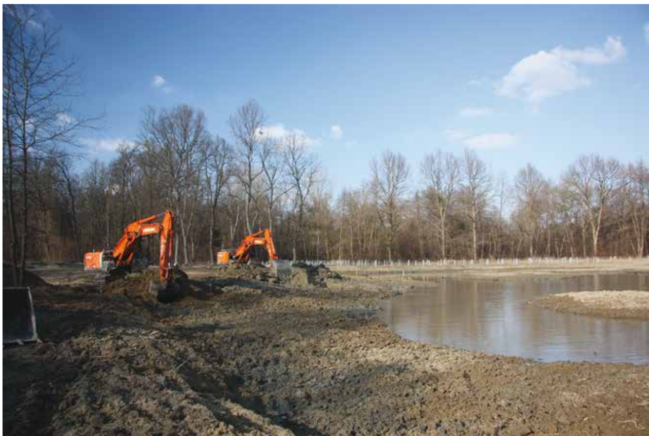
Figura 8 - Operazioni di scavo e profilatura delle zonazioni del canneto, marzo 2019 (foto Fabio Casale).
