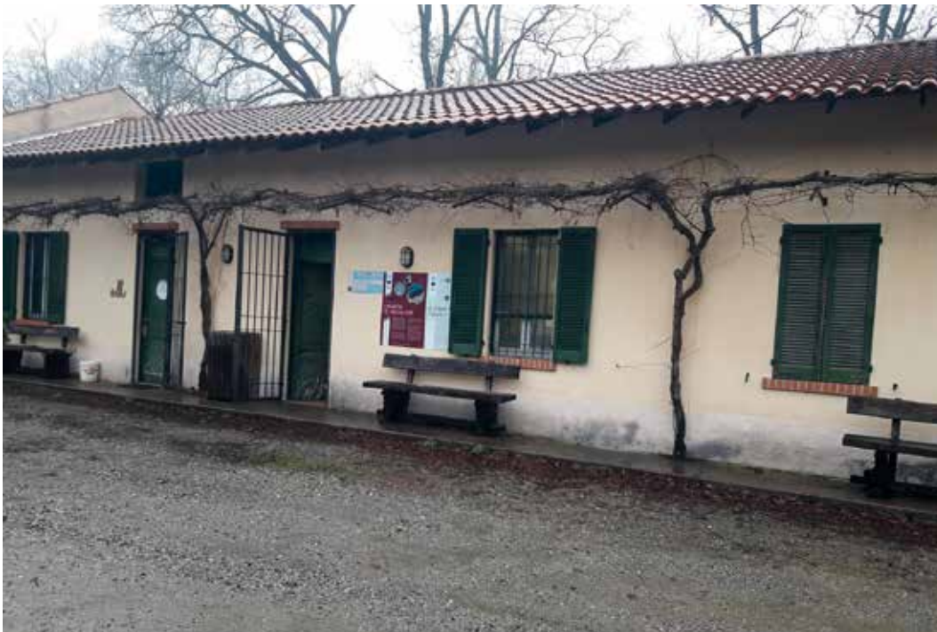
Figura 3 - Edificio che ospita l'incubatoio del Centro Parco "La Fagiana".
