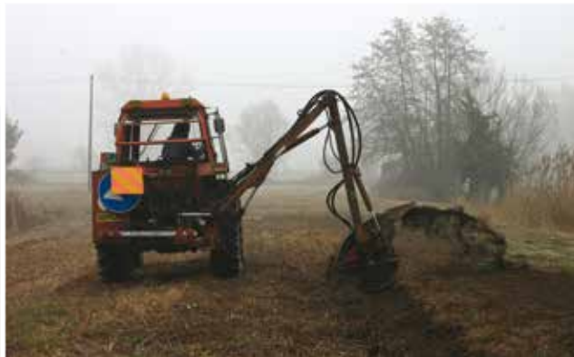
Figura 11 - Operazioni di risagomatura dei fossi (foto Paola Carnaghi).
